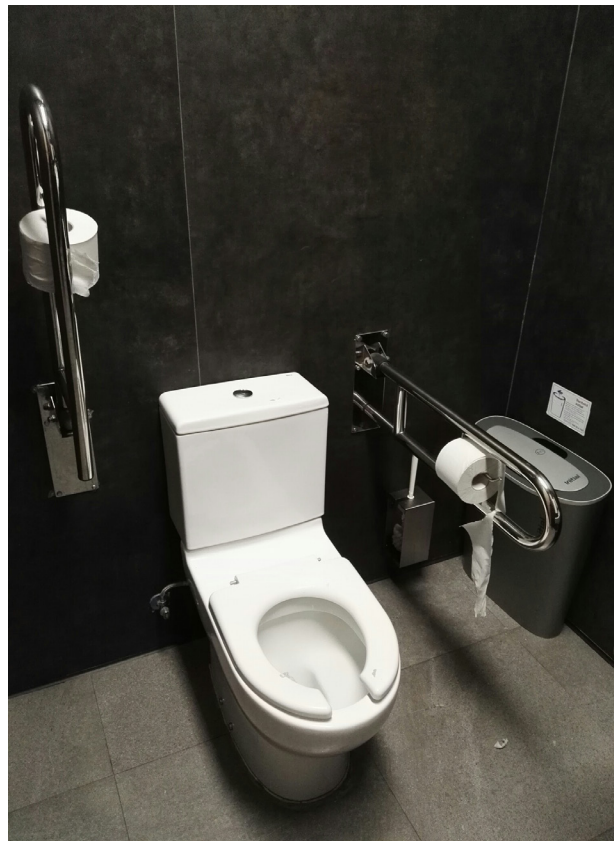
↑ ↗ Fot.7, 8 Wyposażenie toalety dla osoby niepełnosprawnej oraz widok na system przyzywowy zamontowany w toalecie. Fot. Agnieszka Labus, 2016.
