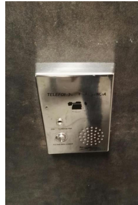
↑ ↗ Fot.7, 8 Wyposażenie toalety dla osoby niepełnosprawnej oraz widok na system przyzywowy zamontowany w toalecie. Fot. Agnieszka Labus, 2016.
