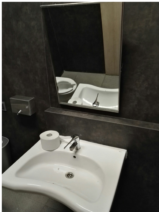
↓ ↘ Fot.5.6. Umieszczenie umywalki oraz ruchomego lustra w toalecie przystosowanej do potrzeb osób niepełnosprawnych. Fot. Agnieszka Labus, 2016.
