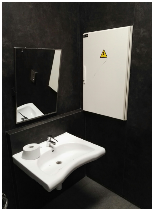
↓ ↘ Fot.5.6. Umieszczenie umywalki oraz ruchomego lustra w toalecie przystosowanej do potrzeb osób niepełnosprawnych. Fot. Agnieszka Labus, 2016.
