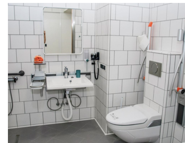
Fot. 7. Łazienka – wyposażenie dostosowane do potrzeb osób niepełnosprawnych (Hewi). Autor: Victoria Kolysyk, 2016.
