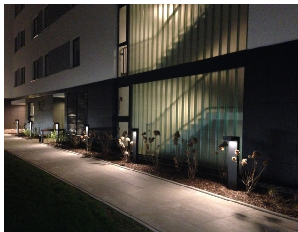
↓ Fot. 49 Przykład oświetlenia sztucznego ciągu pieszego przed budynkiem. Światło równomiernie oświetla powierzchnie chodnika. Autor: Iwona Benek, 2016.
