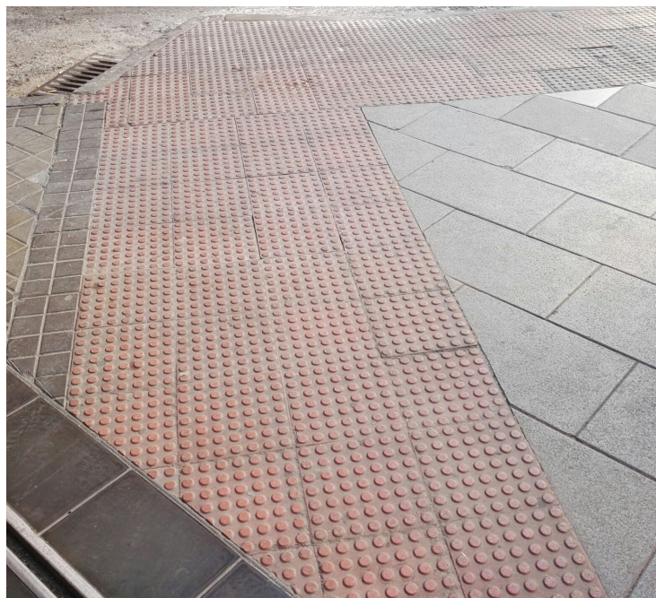
Fot.5 Różnicowanie nawierzchni chodnika – widok na tzw. pas ostrzegawczy. Autor: Agnieszka Labus, 2016.
