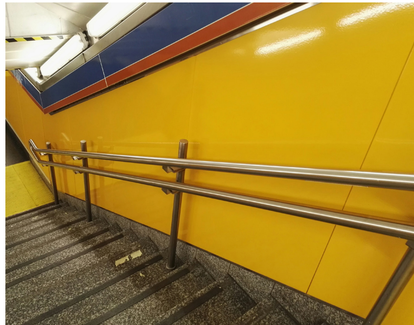
← Fot.33 Schody ze skontrastowanymi powierzchniami ścian i posadzki. Autor: Agnieszka Labus, 2016
