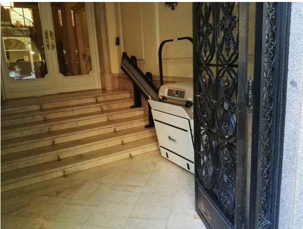
↑ Fot.19. Podnośnik schodowy w budynku zabytkowym. Autor: Agnieszka Labus, 2016.
