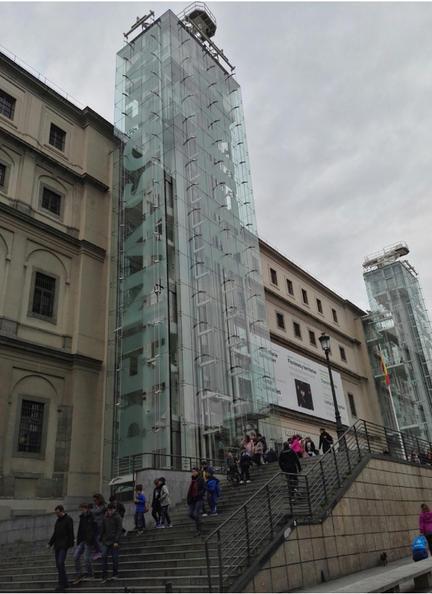
↓ ↗ Fot.17, 18. Winda zewnętrzna dobudowana do zabutku. Autor: Agnieszka Labus, 2016.
