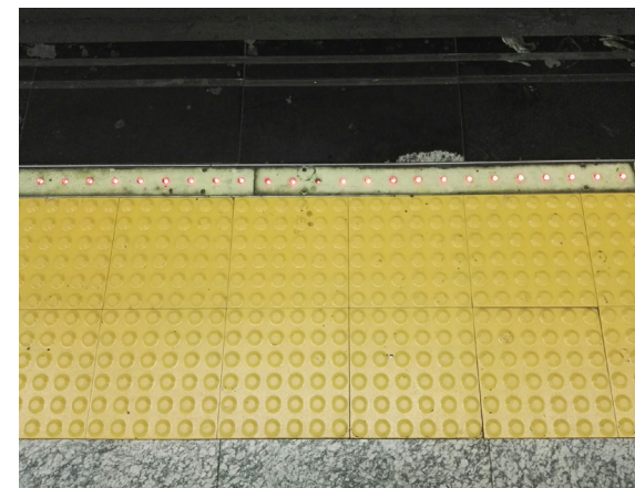
Fot.6, 7 Pasy prowadząco-informacyjne oraz pasy ostrzegawcze na posadzce peronu kolejowego w Madrycie. Autor: Agnieszka Labus, 2016.
